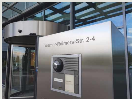
(2 BK-Stelen als Monolith aus Edelstahl mit nach innen gehenden Klappen, spritzwassergeschützt)
