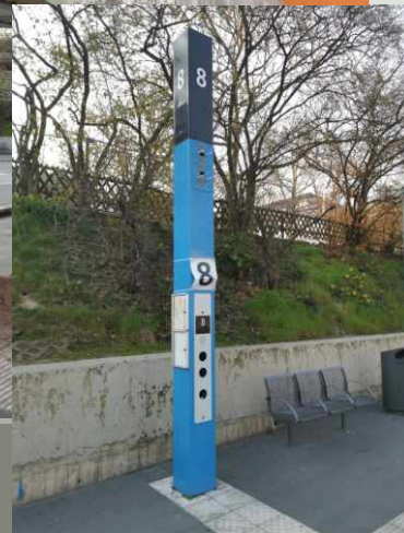
24 Stelen aus Vier- kantstahlrohr 6,3mm 4.850x300x300mm mit Bedienfeld für Elektronik, Aufnahme für ein DFI, Revisions- klappen, aufgesetzten Brailleschildern, Bussteignummern und Anti-Graffiti- schichtung
